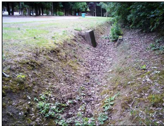
Photo 6 : Exemple de fossé d'infiltration présent sur la BPAL des Boucles de Seine
