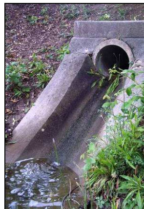
Photo 8 : Arrivée dans le bassin
