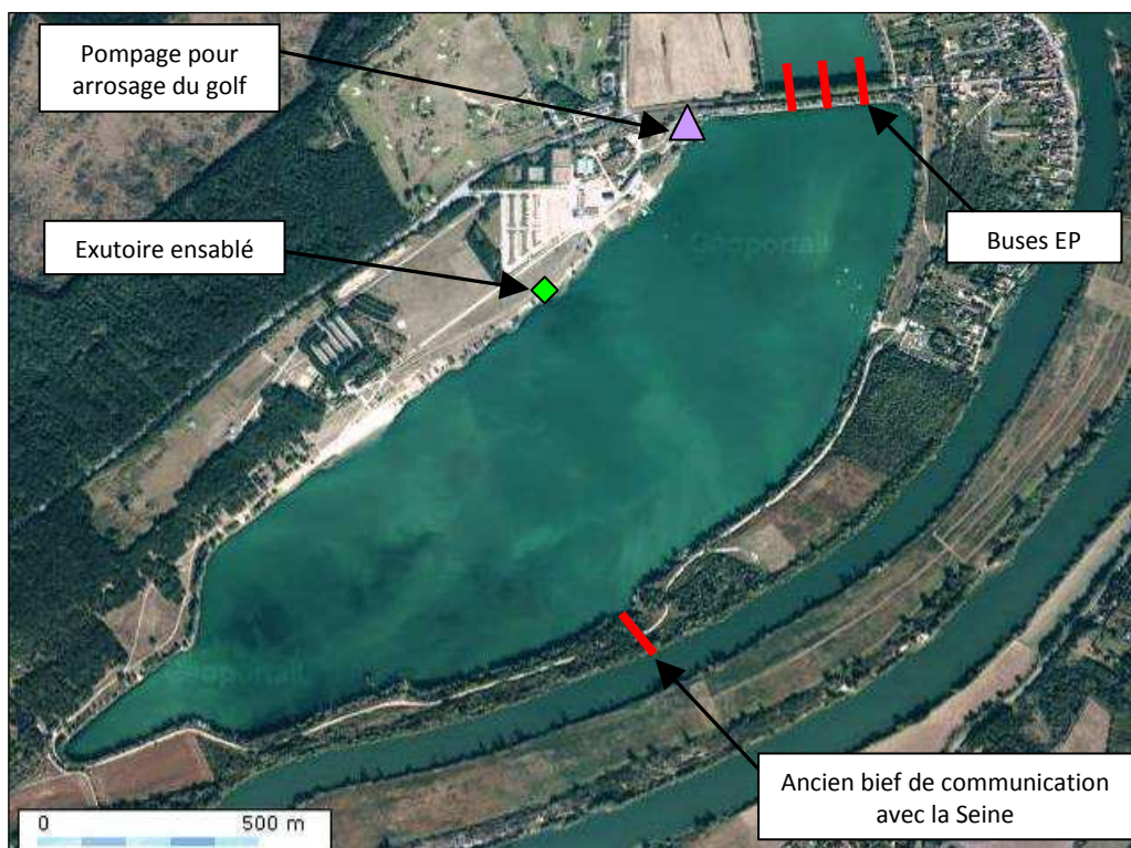
Figure 5 : Ouvrages hydrauliques du plan d'eau de la base de Loisirs
