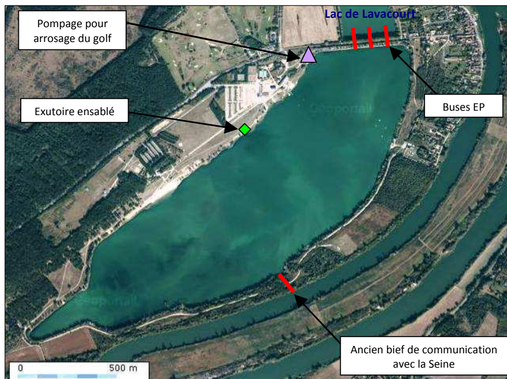
Figure 14 : Ouvrages hydrauliques du plan d'eau de la base de loisirs
