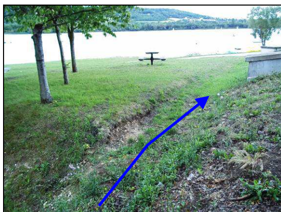
Photo 9 : Déversoir de trop plein vers le plan d'eau
