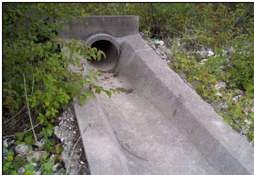
Photo 3 : Buses exutoires de fossés EP vers le plan d'eau de la base de loisirs
