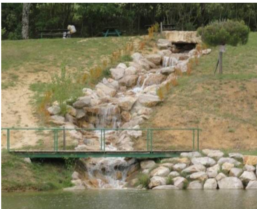
Figure 2 : Cascade d'alimentation en eau de la zone de baignade ©ETEN Environnement
