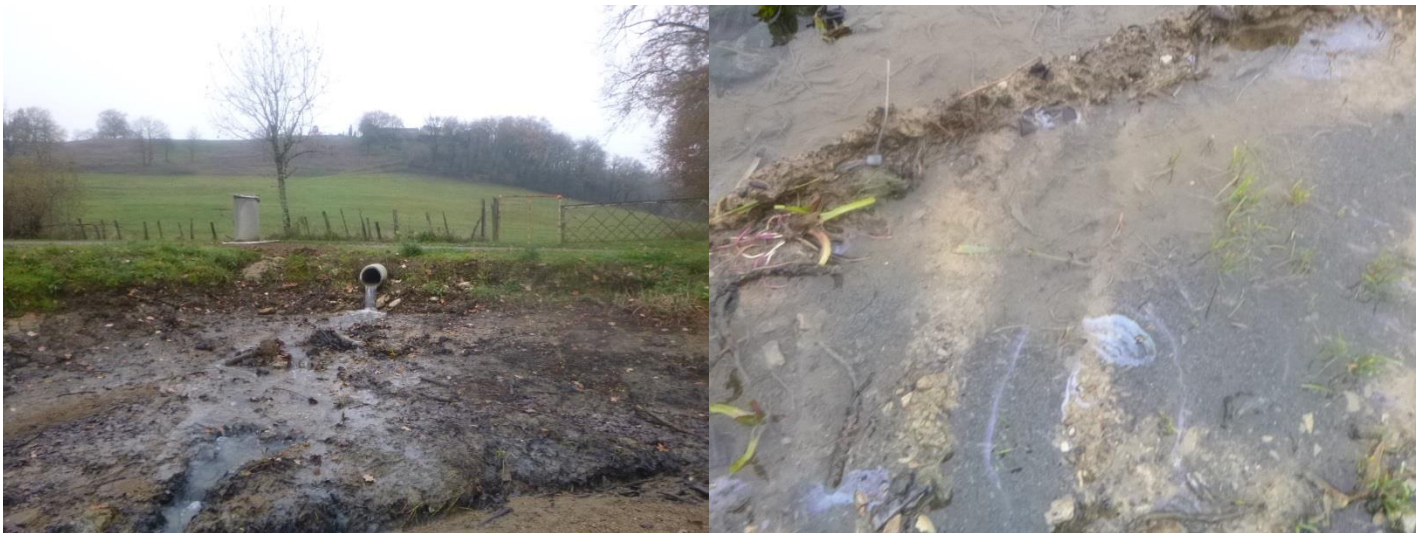
Photo 6: Rejet buse pluviale Ouest / traces d'hydrocarbures post précipitations (chemin du lac)
