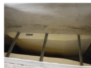
Vue sur le canal de rejet
