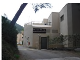
Vue générale de la station d'épuration
