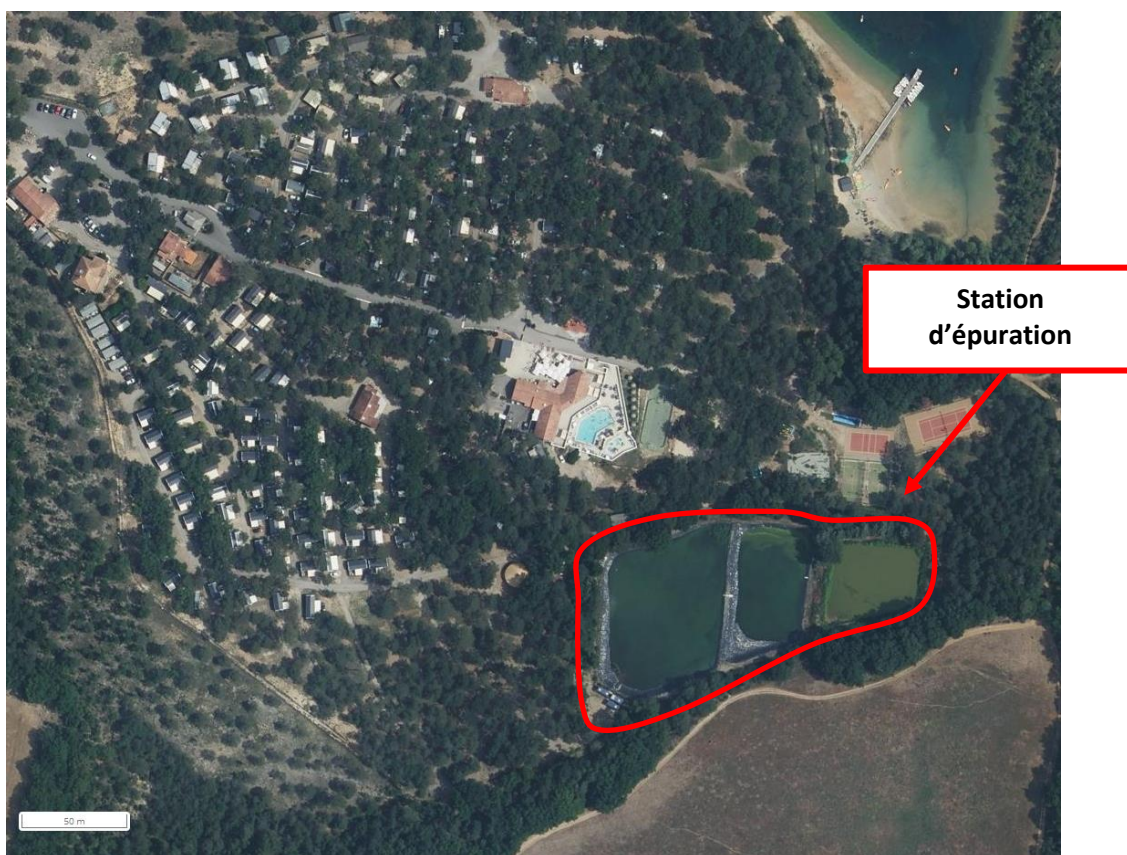
Vue aérienne de la station d'épuration Camping privé« La Farigoulette » de 2021 (Source : Google Earth)
