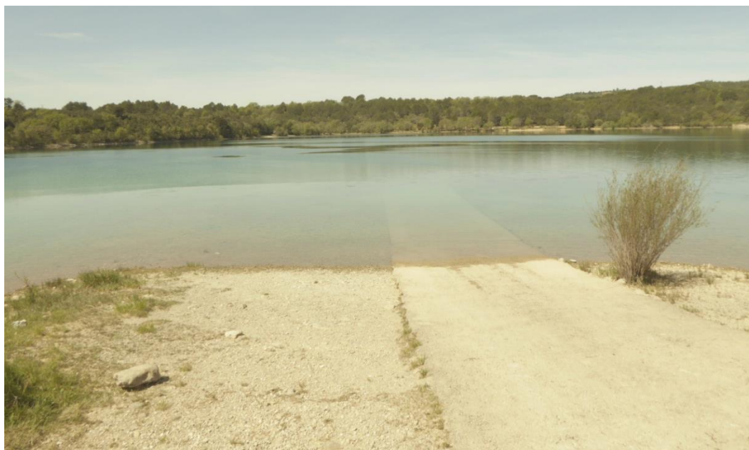
Vue de la cale de mise à l'eau (Photo CIEL mai 2019)
