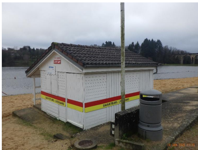
Figure 2 : Poste de secours (Crédit photo : Géonat, 2026)
