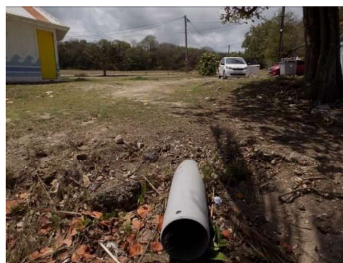
Exutoire d'eaux pluviales
