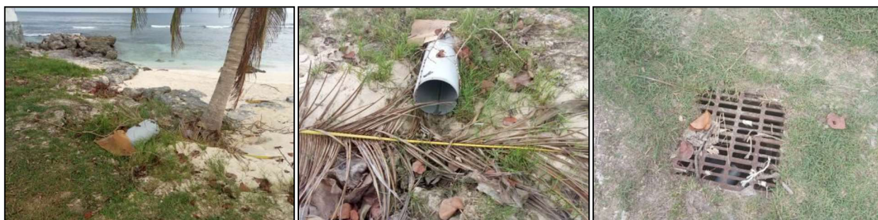
Figure 16 : Photos de l'exutoire et de son réseau
