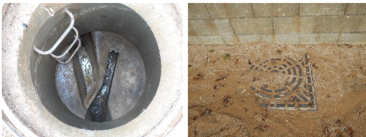
Figure 30 : Déversoir d'orage du camping (gauche) et réseau collectif (droite)
