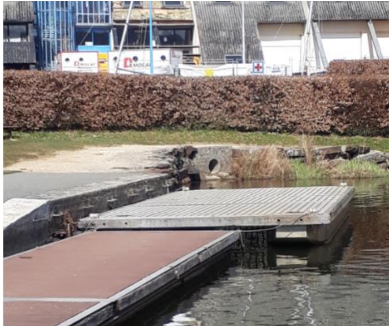
Figure 44 : Photographie de l'exutoire des eaux pluviales situé à proximité du centre des congrès (source : IRH, 2021)
