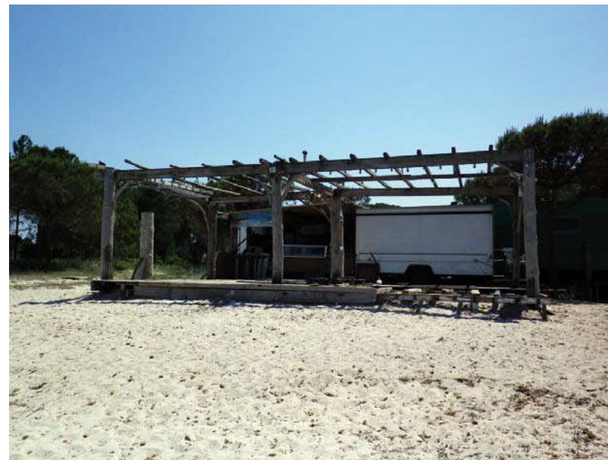
Charpente de restaurant saisonnier démontable ("paillote")
