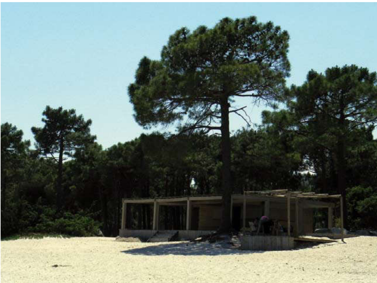
Paillotte en construction dans la partie sud de la plage
