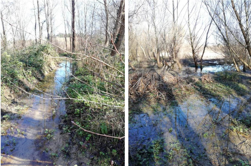
Nettoyage de la zone humide : création d'un canal
