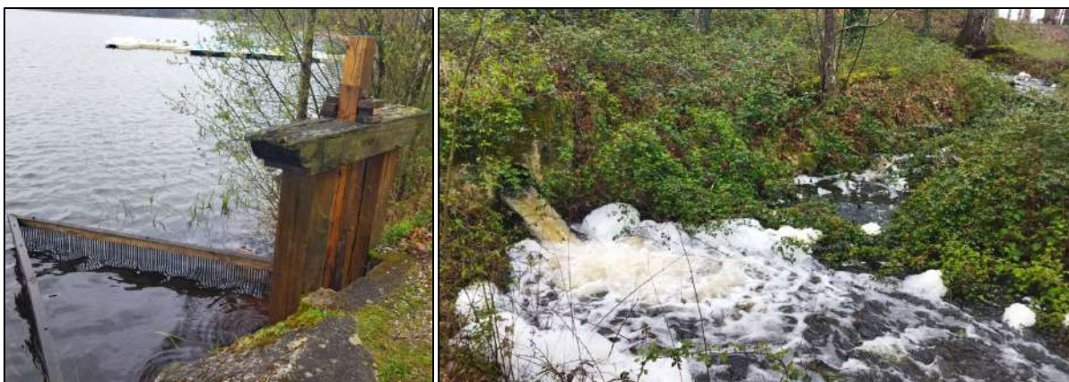
Figure 13 : Ouvrage de sortie (n°2) côté amont (à gauche) et aval (à droite)
