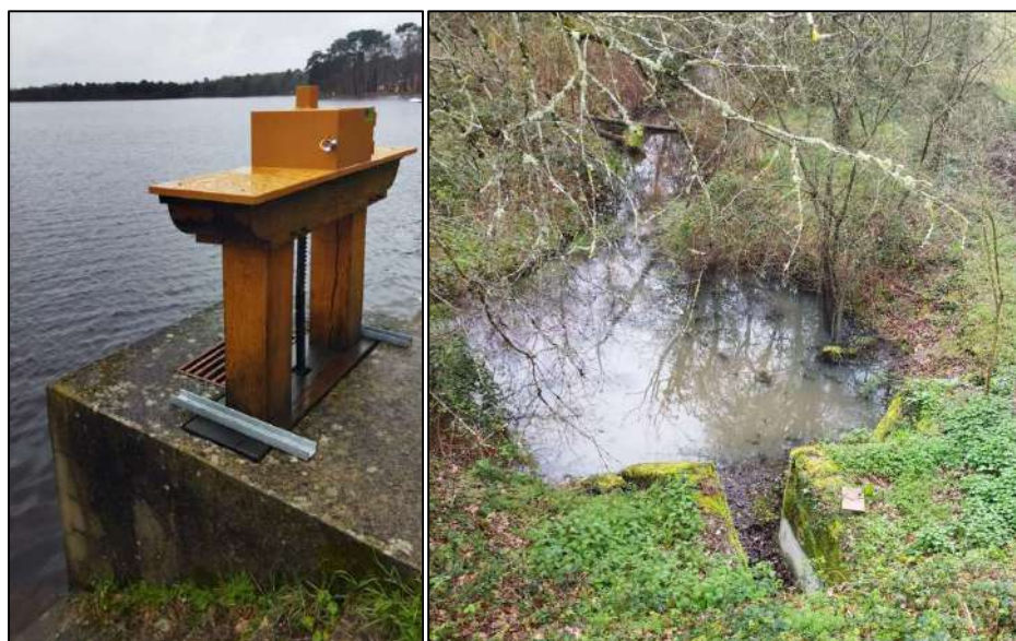
Figure 12 : Ouvrage de sortie (n°1) côté amont (à gauche) et aval (à droite)
