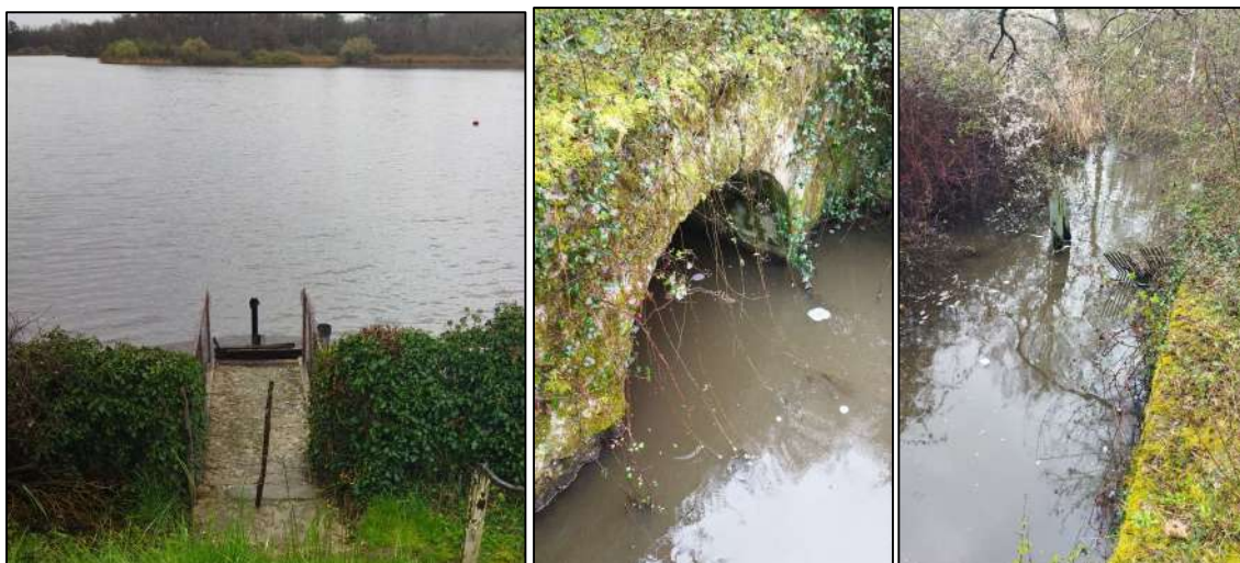
Figure 16 : Ouvrage d'alimentation (n°5) côté amont (à gauche) et aval (au milieu) prolongé par un canal (à droite)
