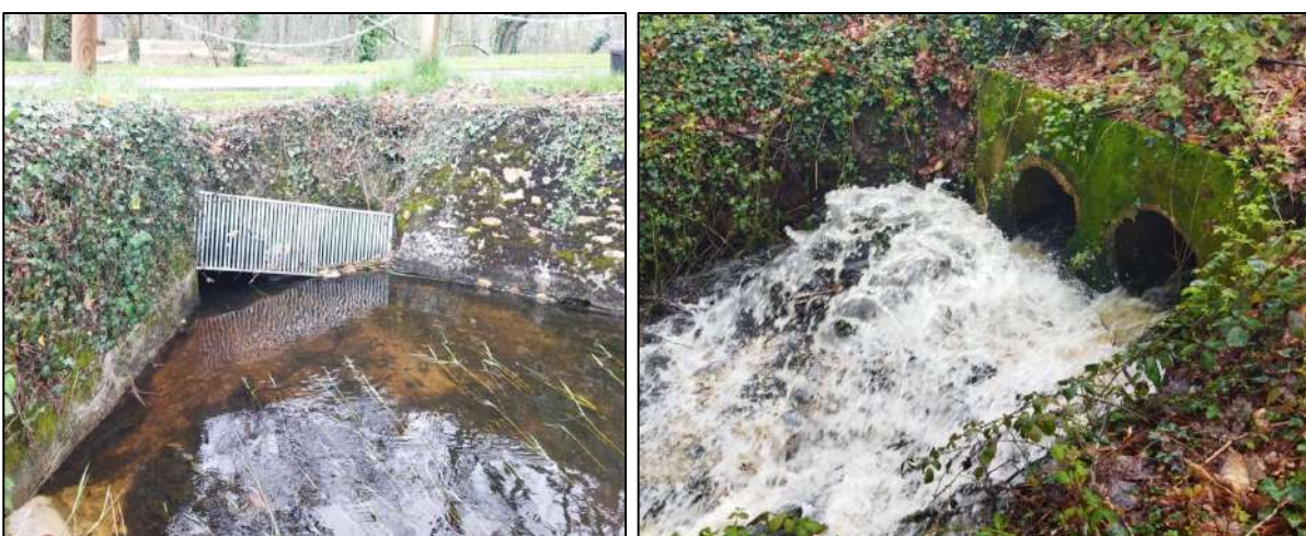
Figure 14 : Ouvrage de sortie (n°3) côté amont (à gauche) et aval (à droite)
