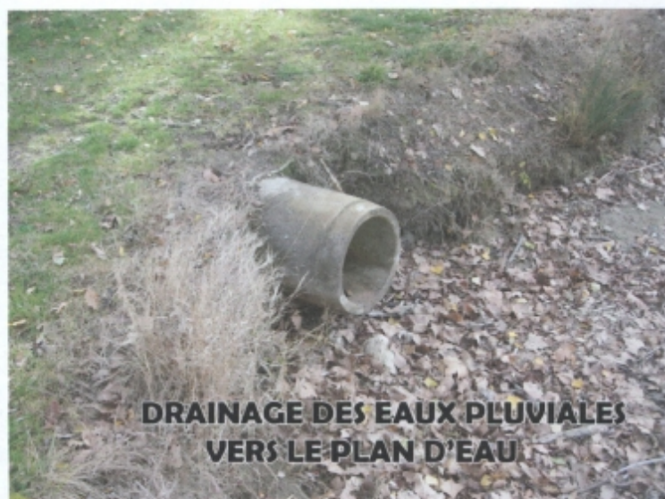
Photo 2 : drainage de l'un des bassins versants secondaires
