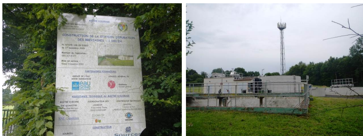
STEP communale (terrain EGIS EAU, 01/07/14)
